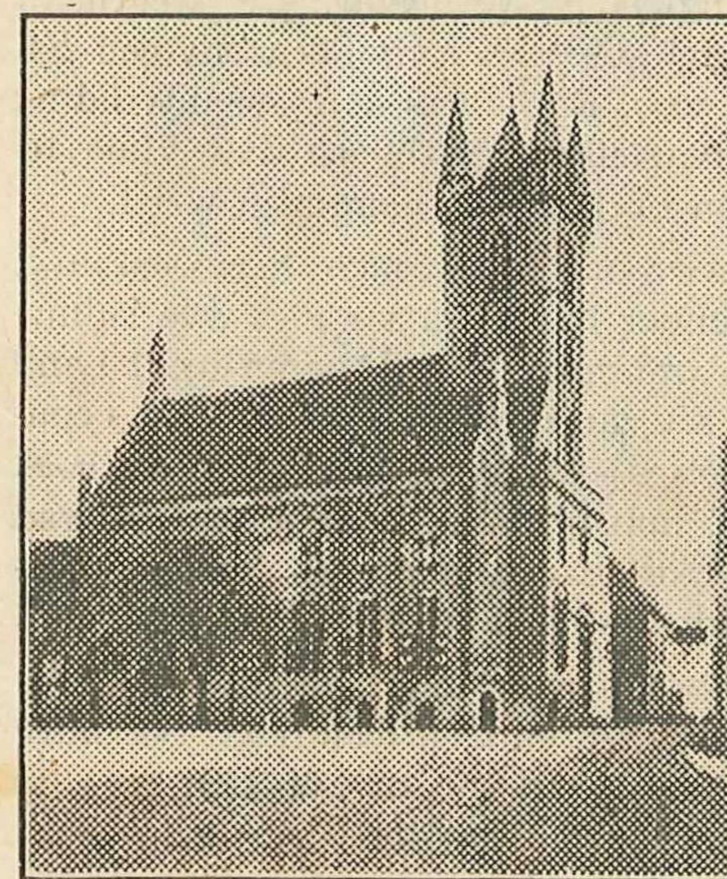
Het Stadhuis van Sluis
